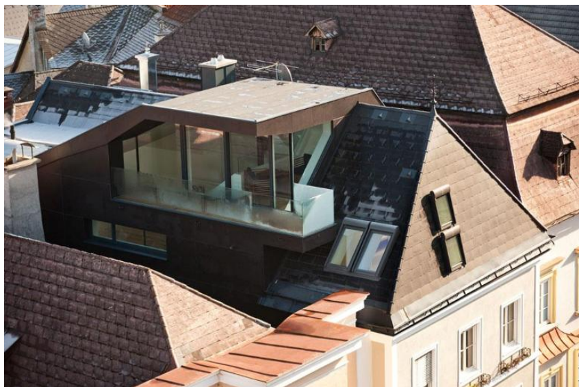
Rigler Wohn- und Geschäftshaus Architekturbüro W30 Innenstadt Waidhofen / Ybbs Durchführung 2011
