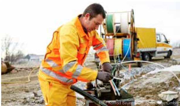
Foto: Konrad Beyer & Co. Spezialbau GmbH
